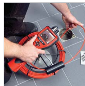
Inspektion von Bodenabläufen
