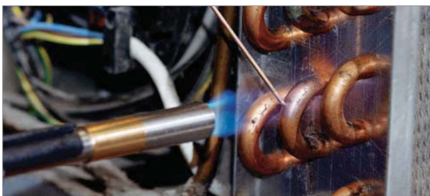
Hartlöten in der Kälte-Klima-Technik
