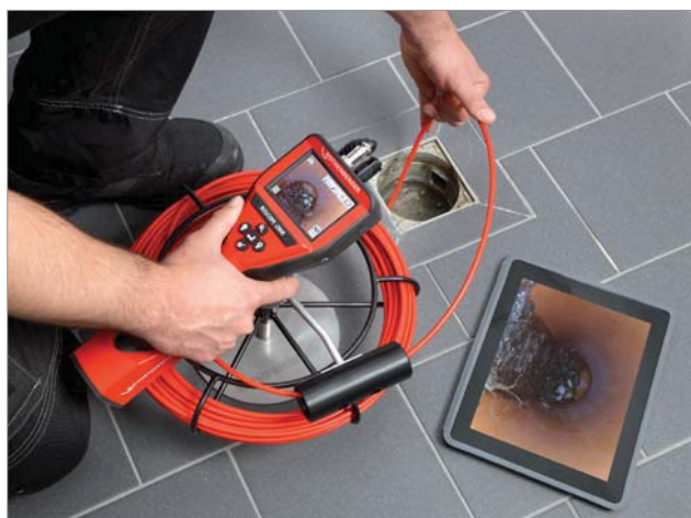
Inspektion von Bodenabläufen
