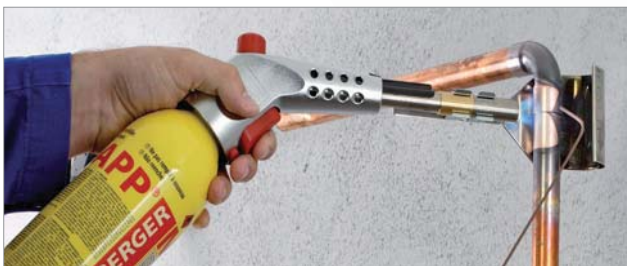
Hartlöten in der Gasinstallation
