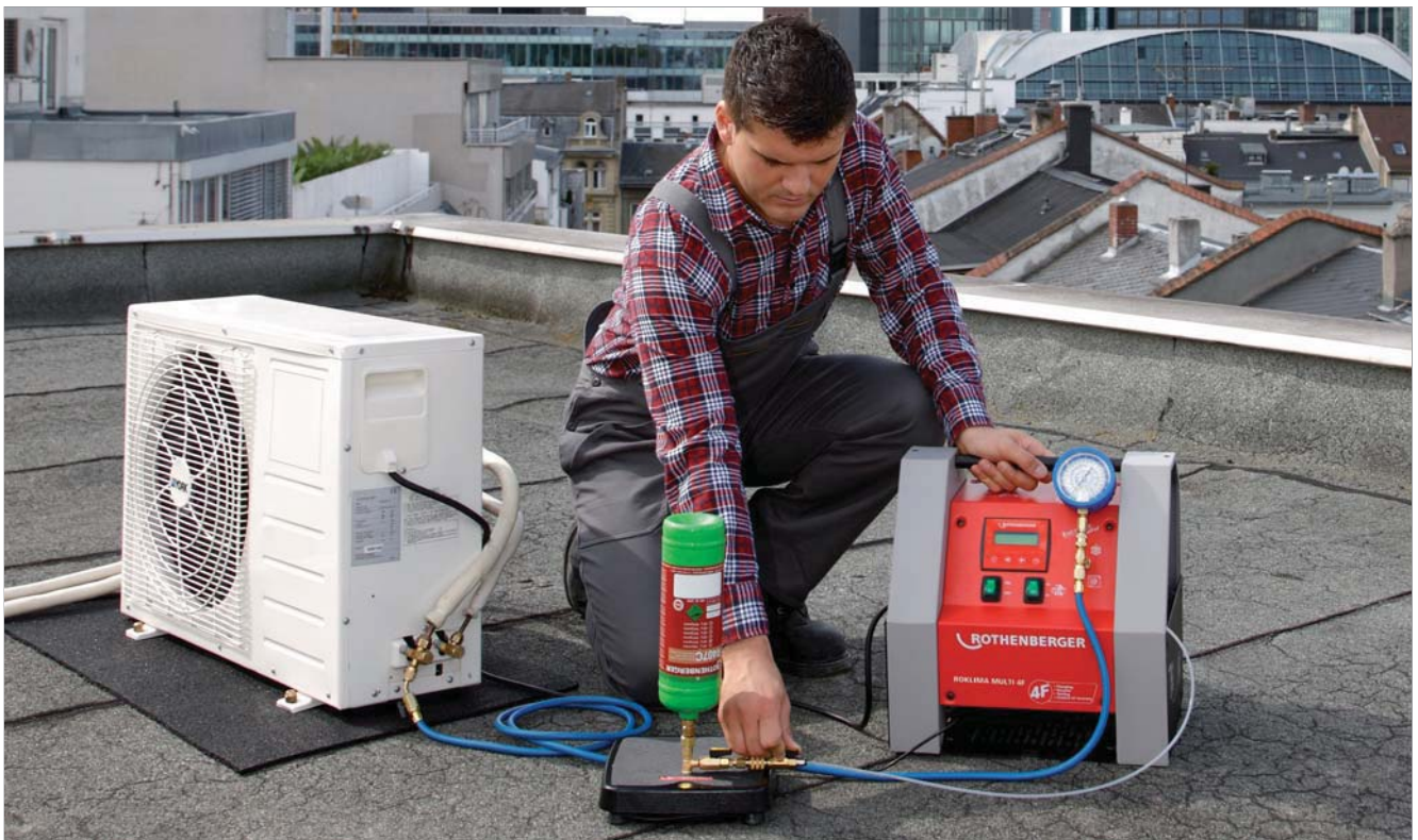
ROKLIMA® MULTI 4F im Einsatz (Evakuieren & Befüllen)
